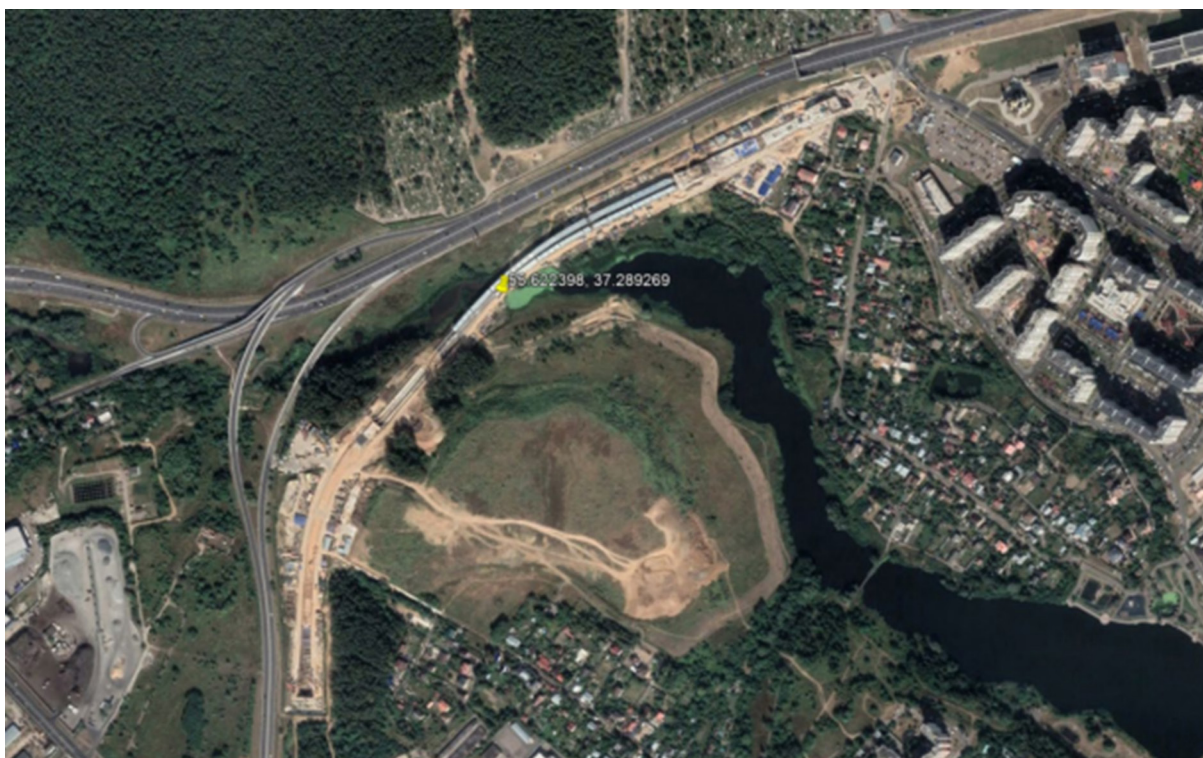
Рис. 2.3.8 Участок строительства метромоста через реку Ликову
