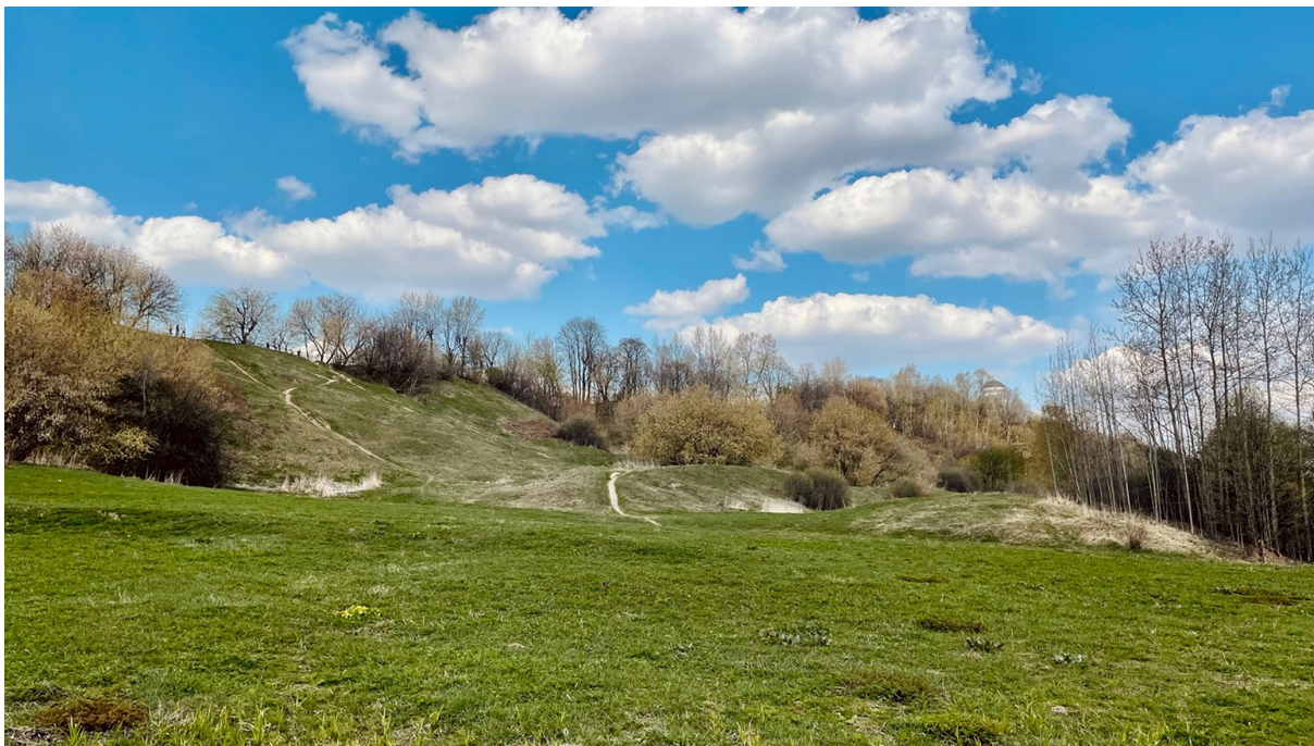
Рис. 2.4.11 Оползневой склон в Коломенском
