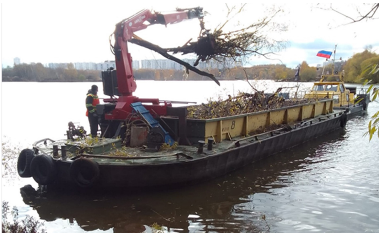
Рис. 2.3.5 Проведение работ по удалению древесного мусора из русла р. Москва в районе Покровское-Стрешнево
