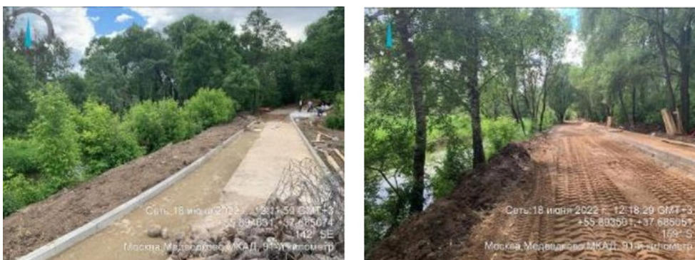
Рис. 2.3.9 Работы по благоустройству прибрежной территории вблизи реки Яуза, 2022 г.
